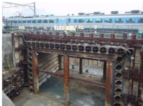
施工完了写真
